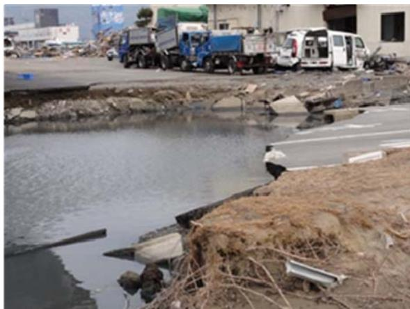
写真1 漁港近辺の道路(一部が陥没している。)
