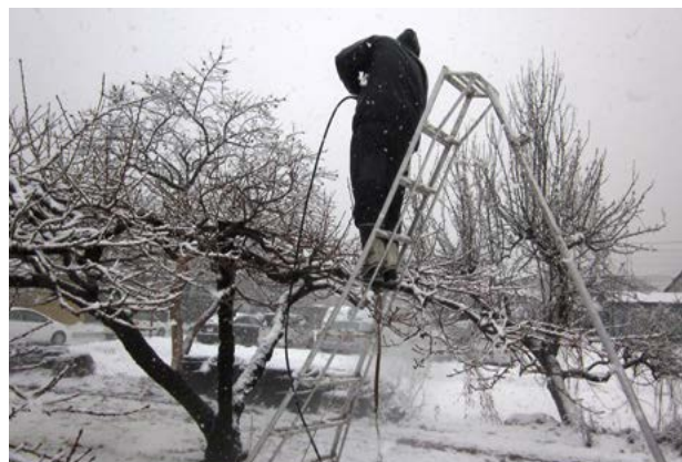
写真3 上枝の除染は足場を使い作業
