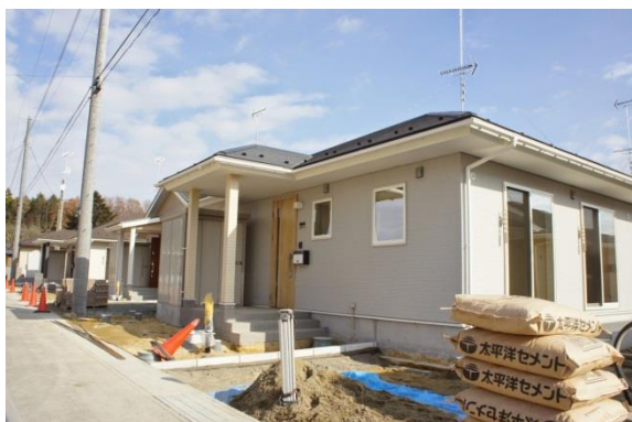
写真 3 新地駅周辺整備遠景
