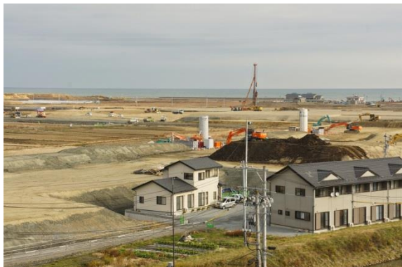
写真 5 橋脚等の建設が進む常磐線内陸移設工事
