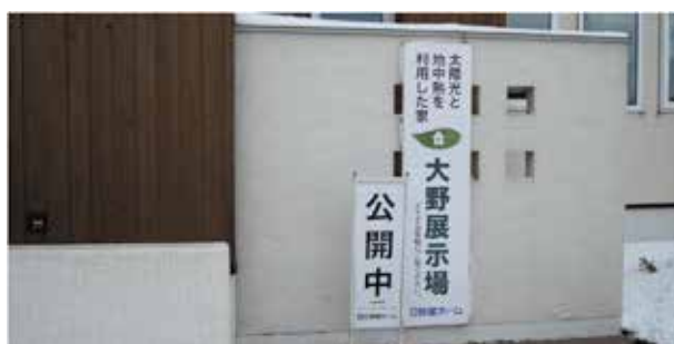
青森市内に設置された地中熱利用モデルハウスの概観（左）と室内設置の地中熱利用ヒートポンプによる給湯パネル（右）（青森市日野建ホーム大野展示場）
