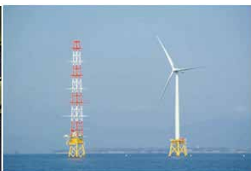
設置された洋上風車（左は洋上風況観測塔）
