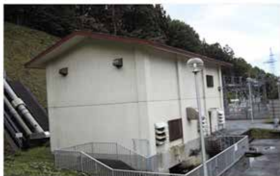
西目土地改良区の発電所外観
