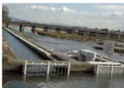
嵐山保勝会SHPP, 京都嵐山 (一級河川 桂川) 落差:1.74m、流量:0.55m 3 /s 出力:5.5kW, 2005
