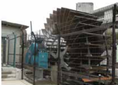
家中川SHPP 都留市 (準用河川 家中川) 落差:2m、流量:2m 3 /s 出力:20kW, 2005
