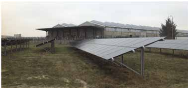
地面平置きと建物の屋根設置のモジュール
