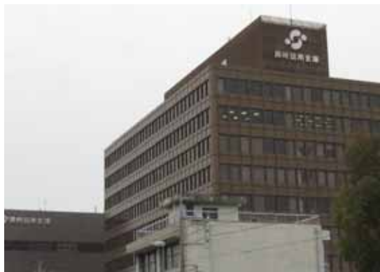
写真 岡崎信用金庫本店（09年3月10日撮影）
