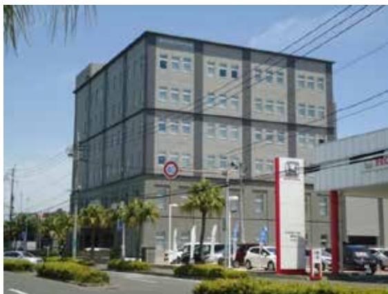
写真1 鹿児島相互信用金庫本部の外観
