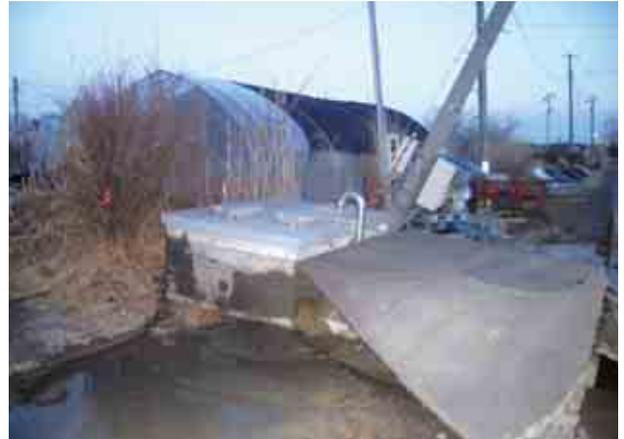
地下水路の損壊による被害(福島県矢吹町)
