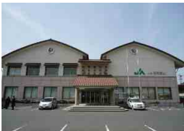
写真1 JA石見銀山 本所
