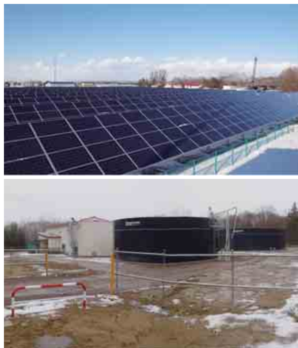
メガソーラー発電所(上)とバイオガスプラント(下) (写真：(株)エネコープ提供)
