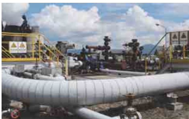
生産井(秋田県上の岱地熱発電所)
