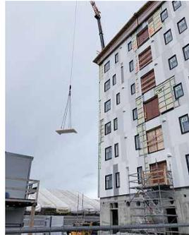
写真4 Lighthouse Joensuu (2019年竣工予定、写真はCLTパネルを釣り上げる様子。)
