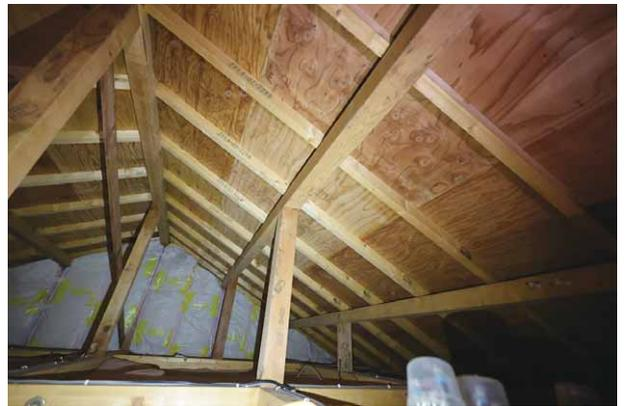
写真18 屋根裏から雨漏りは確認されず、母屋、垂木、構造用合板にはシロアリ被害や腐朽は見られない
