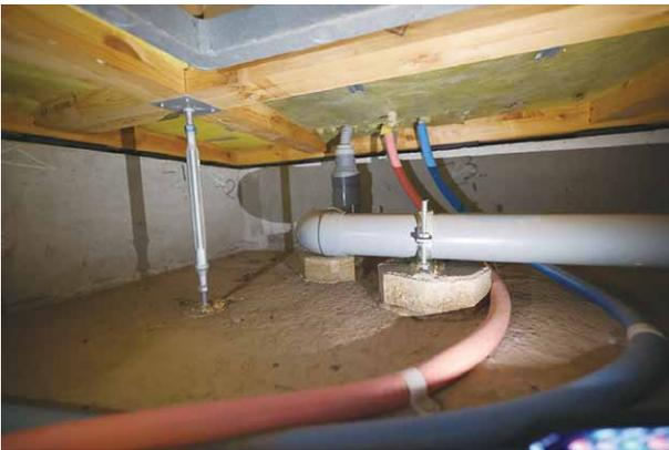
写真17 湿気等によるベタ基礎のひび割れはなく、土台や大引きにシロアリ被害や腐朽は見られない
