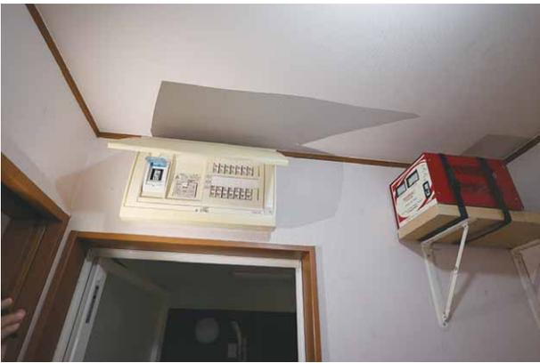
写真7 分電盤と変圧器
