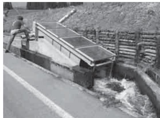
農業用水路に設置した小水力発電 (らせん式0.8kW、石徹白地区)
