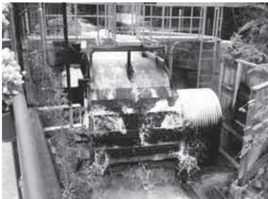
上掛け水車による小水力発電 (19kW, 都留市)
