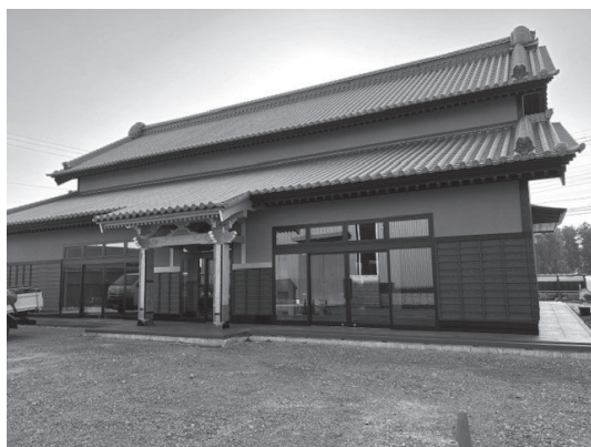
写真1 工場内に販売店を設け施設への来客を期待
