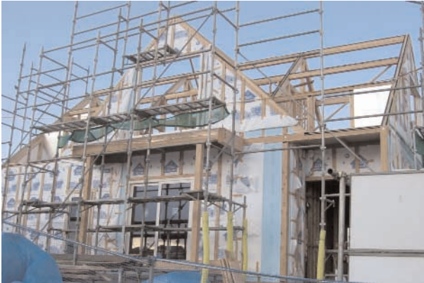
プレカット材の組立て現場
