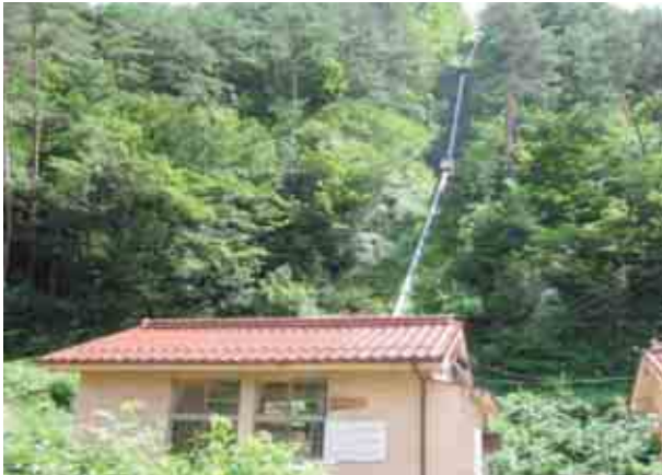
写真1 118mの落差を持つ所山発電所 (山の上部から下がっているものが水管)
