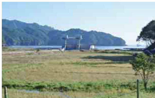
堤防が壊れ津波で冠水した唐丹下荒川地区のほ場
