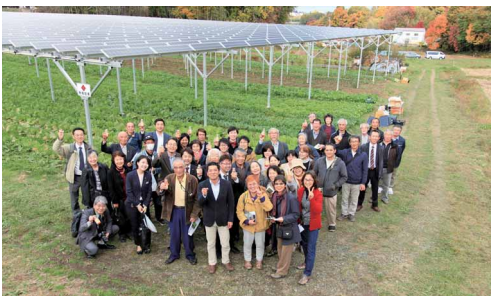
「営農型発電所」の完成式。それぞれが「にんじんジュース」を手に持って乾杯。 (写真：飯館電力提供)
