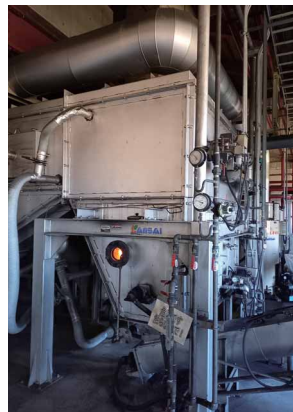
自動粃殻炭化装置の炭化炉と製造・販売するバイオ炭(筆者撮影)
