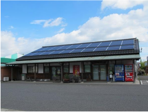
写真 10-2 とりちく若葉台発電所(直売所)
